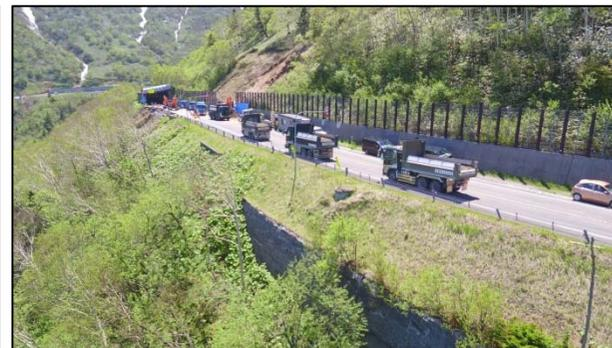
i-Constructionは、施工中の丁張り設置や密度試験の待ち時間が発生しないため、重機・ダンプの施工ロスを防止し、日当りの盛土施工量を高める事ができた。
