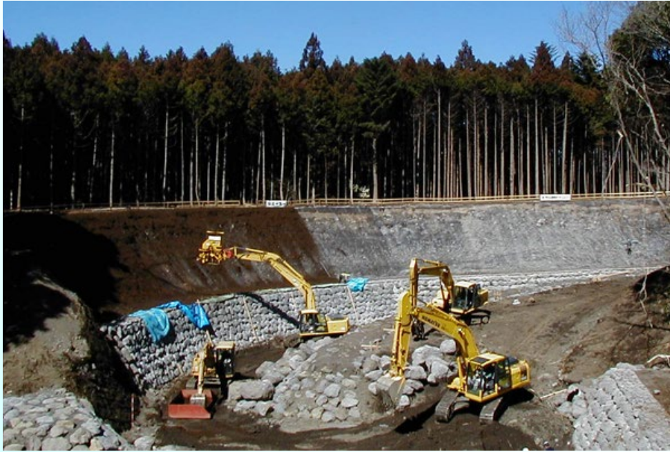
ネッコチップ工法施工状況
