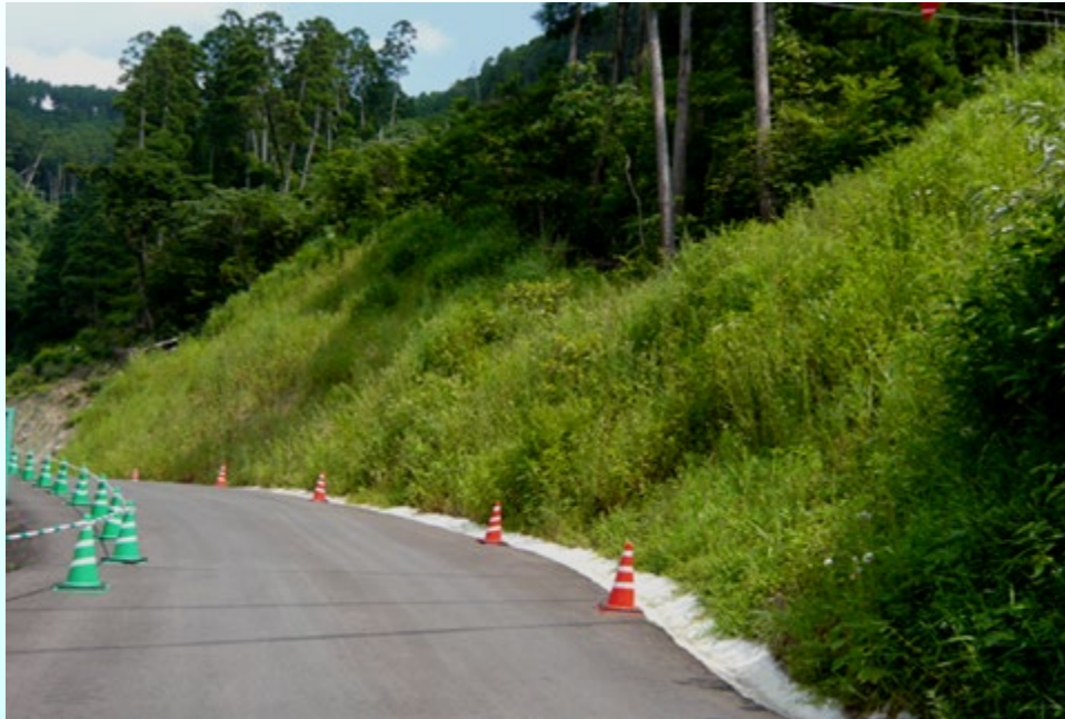
植生状況 施工後 5ヶ月
