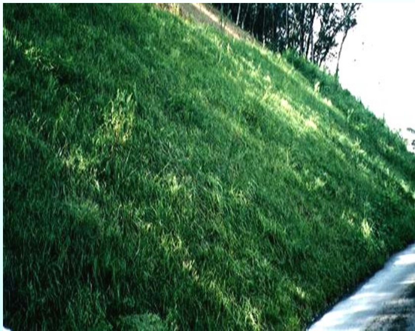
植生状況 施工後7ヶ月
