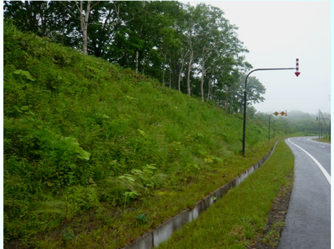
植生状況 施工後 3年6ヶ月
