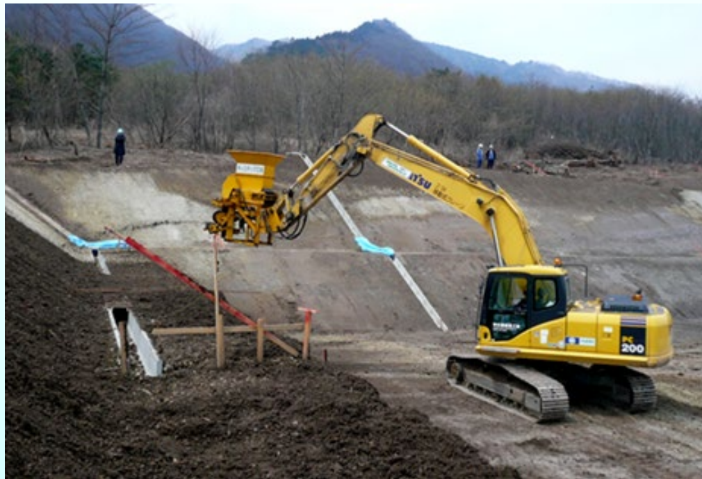
施工状況（標準施工システム）
