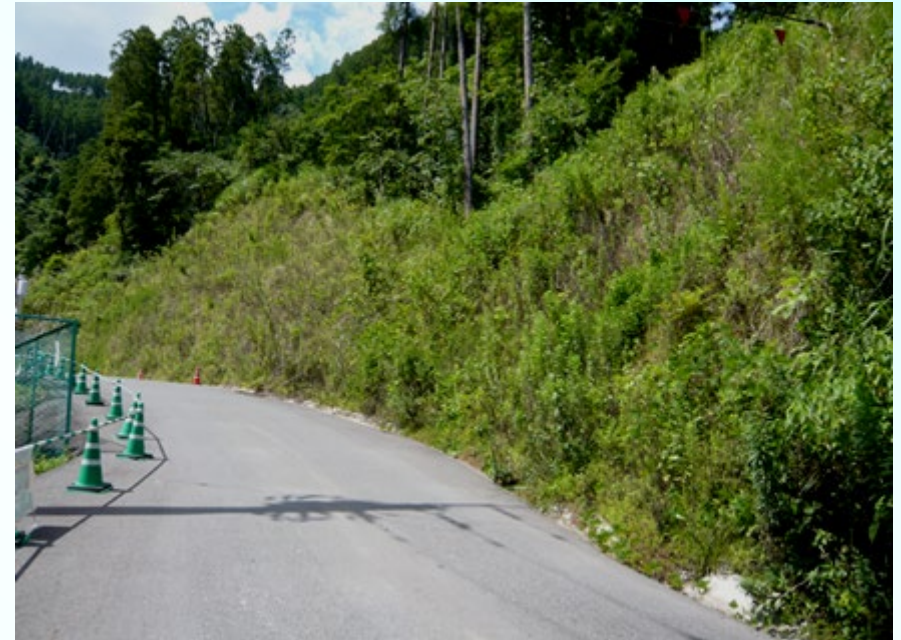
植生状況 施工後 1年6ヶ月
