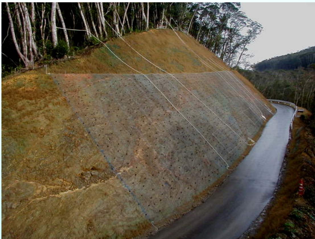
施工前法面状況 法面勾配 1 : 1
