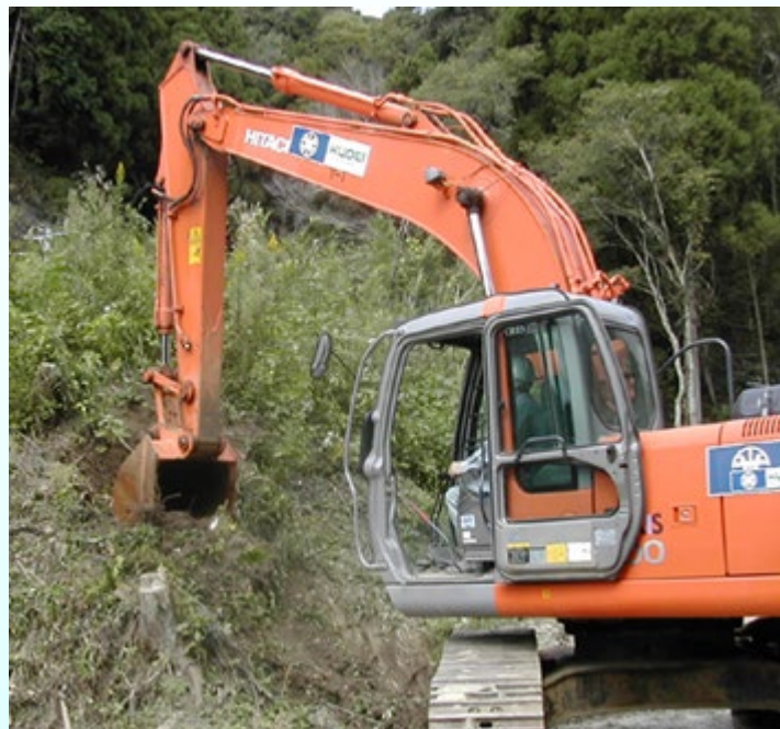
現地発生土・表土の採取
