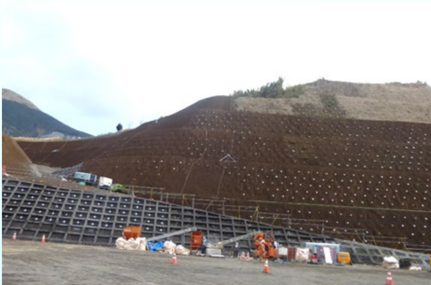
施工後 法面状況
