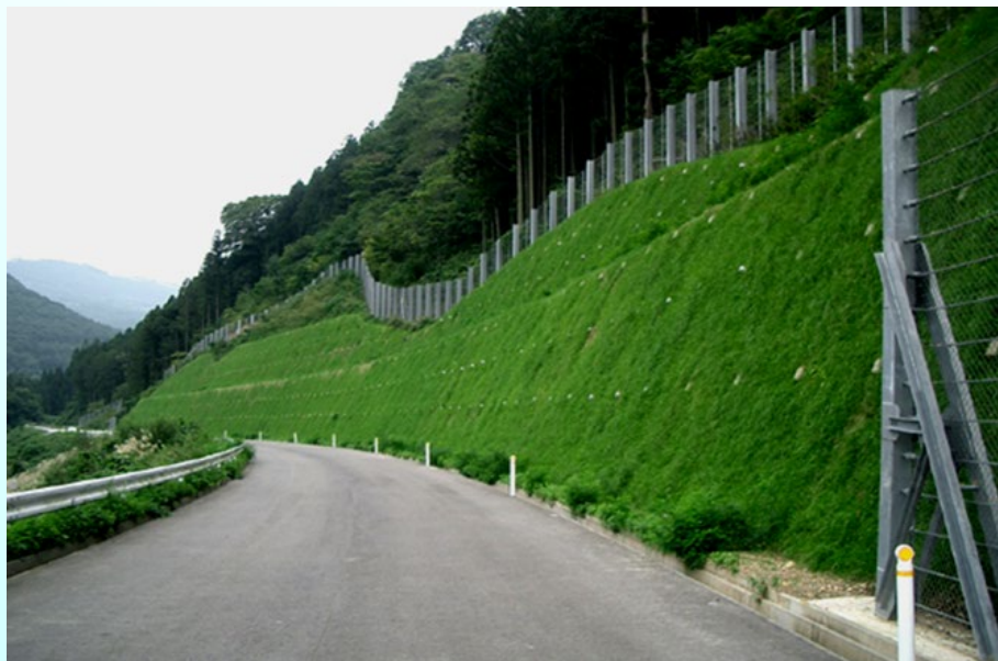
植生状況 施工後 3ヶ月
