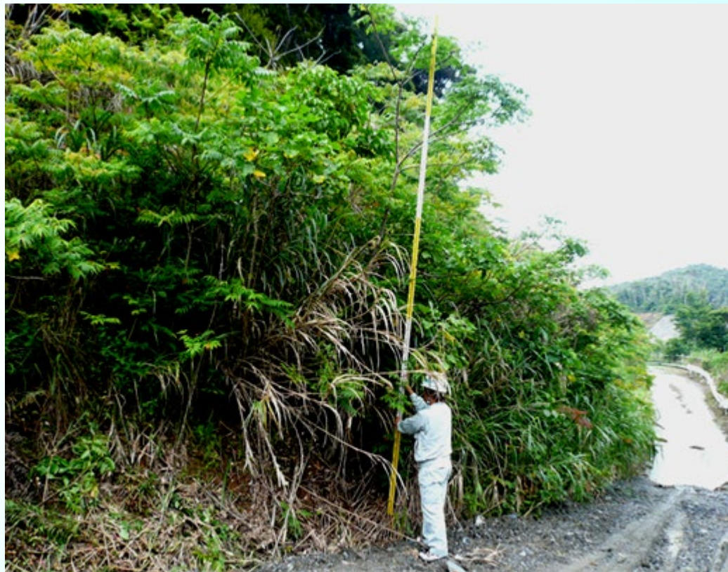
植生状況 施工後6年6ヶ月
