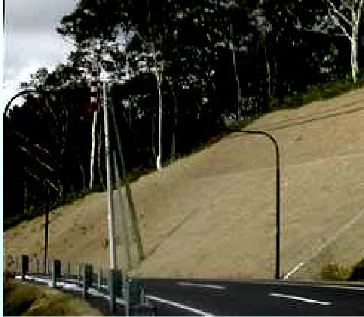
施工直後法面状況
