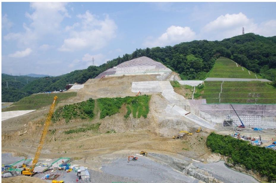
安威川ダムでは、生態系保全が強く求められており、当初設計は、人力による表土採取を用いる工法でした。カエルドグリーン工法はバックホウで表層から50cm程度の表土を含む掘削土を使用できることから、効率的に森林表土を再利用することが可能で、比較的低コストとなることから採用に至った。
