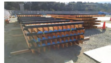
寸法を均一化した木製ルーバー
