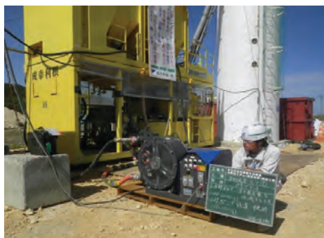
小型ポンプ(手前の機器)の設置
