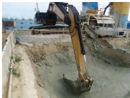
建設汚泥の固化状況
