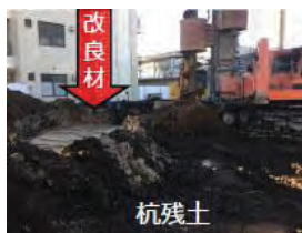
建設汚泥の改良
