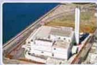
都市ごみ焼却炉
