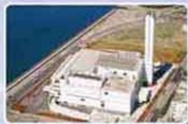
都市ごみ焼却炉
