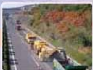
アスファルト撤去
