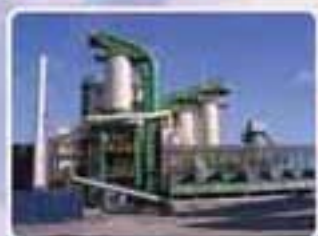
再生アスファルト製造
