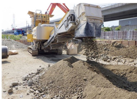
移動式改良機による改良土の状況
