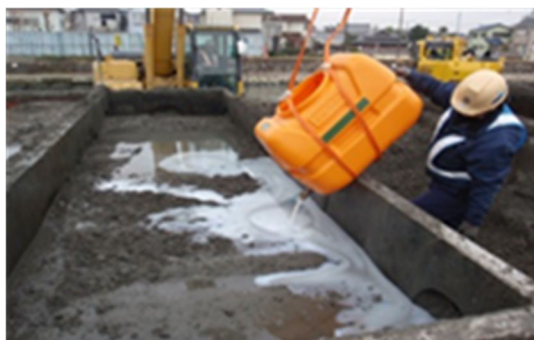
液体固化材 投入状況
