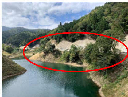
常時満水位～サーチャージ水位の残した樹木
