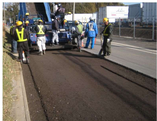
写真-1 CAE 施工状況
