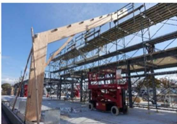
【写真4】 C通り側 柱・梁建て方
