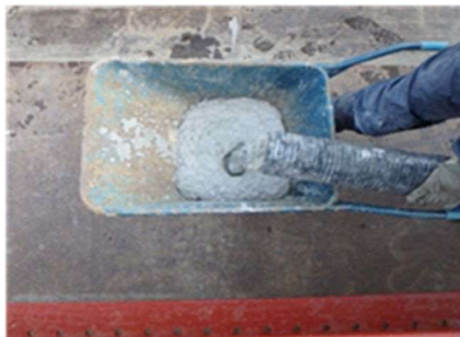
コンクリート打設時に使用する先行材を変更することで残コン削減
