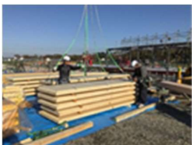
【写真13】中2F床CLT吊り込み
