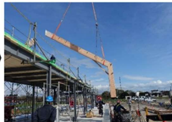
【写真5】 A通り側 柱・梁建て方
