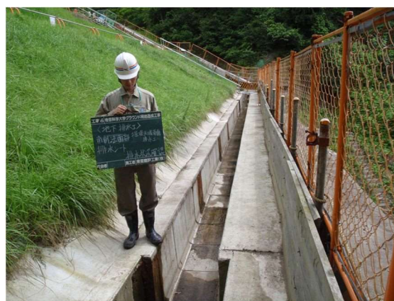
写真-2 水平排水材からの排水状況
