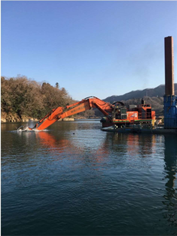
写真-1 相模貯水池での浚渫の状況
