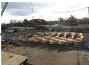
【写真2】 柱・梁の地組
