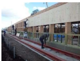
【写真12】壁構造用合板張り
