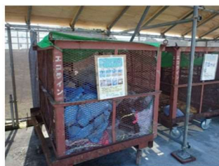
【写真9】産業廃棄物収集カゴの上部はシート囲いとし、各々分別標示を掲示して分別ミスを低減した
