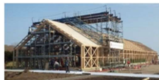
【写真15】移動式足場
