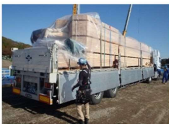
【写真1】 柱・梁材の搬入
