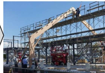
【写真6】 1スパン建て方完了状況
