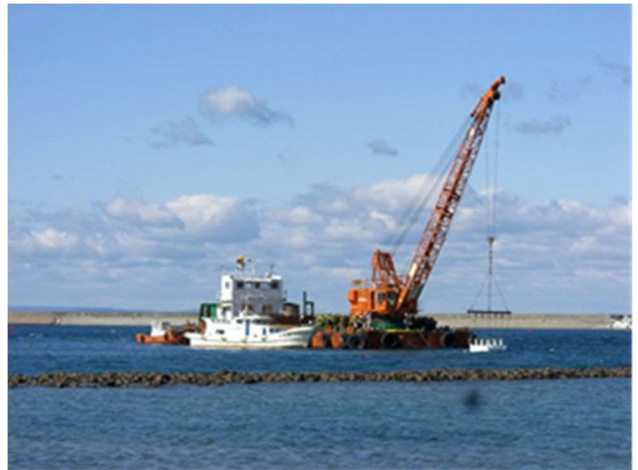
写真-5 ダム湖浚渫土砂による干潟造成実験
