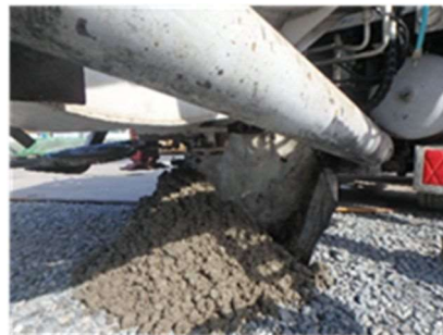
打設時に発生する余剰コンクリートに「改良剤」添加・固化後、適宜作業ヤードの砕石として使用
