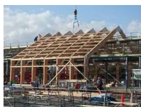
【写真11】大断面集成材建方
