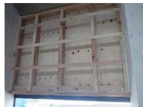
【写真14】内壁下地木軸の施工
