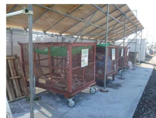
【写真8】産業廃棄物分別ヤードはコンクリート床の屋根付きとした
