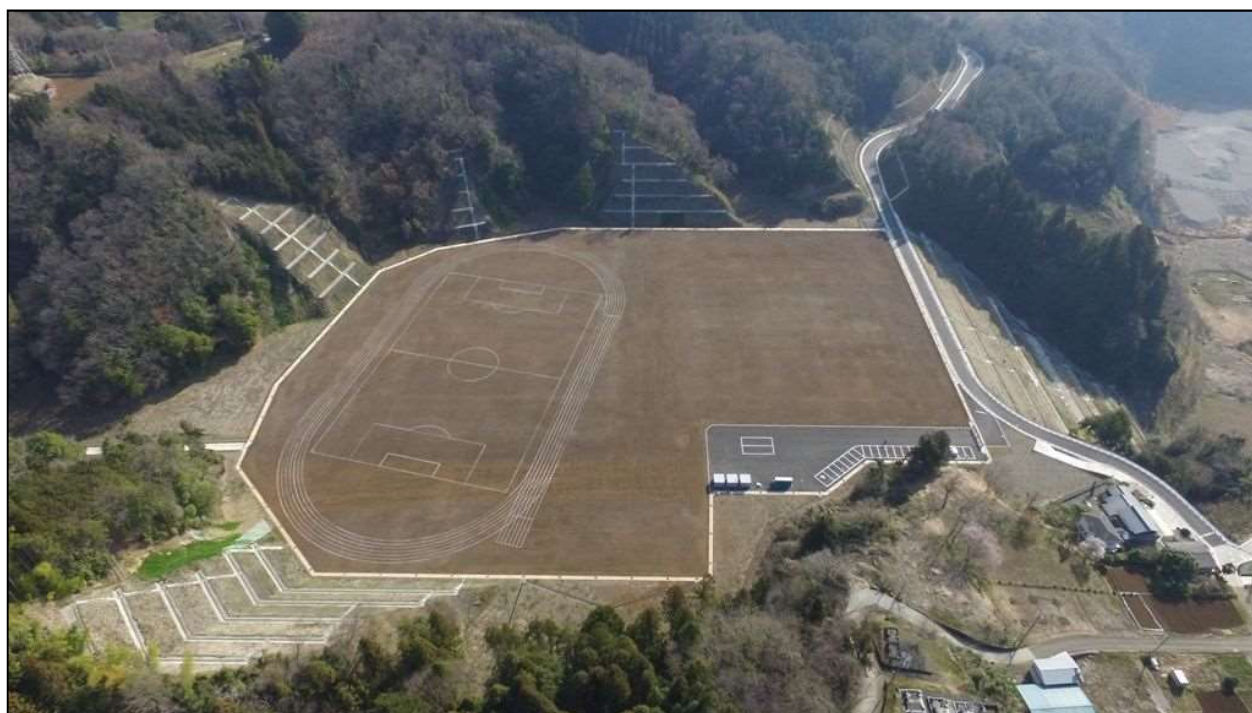
写真-3 造成したグラウンドの全景
