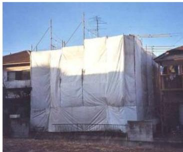
単管一側足場に防災シートで養生した工事例
