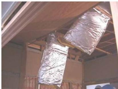
断熱材の撤去状況
