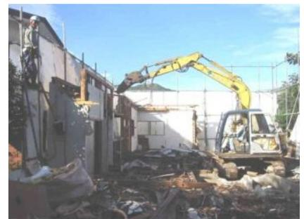
外周部の転倒解体工法による作業の状況
