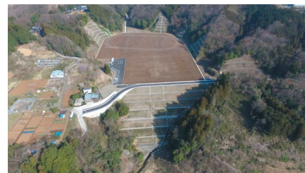
完成したグラウンドの全景
