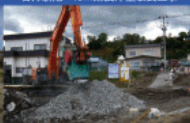
町道浜中入舟線道路改良工事
