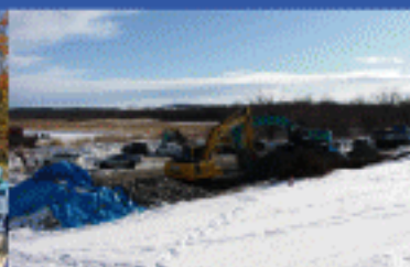
網走川改修住吉築堤漏水対策工事
