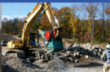
滝野公園駐車場舗装外一連工事
