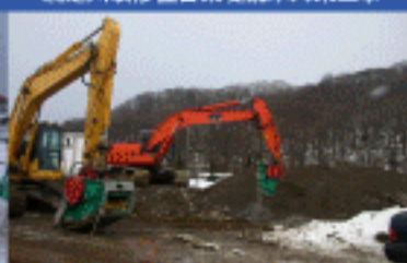
黒松内町陸橋解体工事
