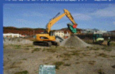
室蘭崎守地区臨港道路改良工事
