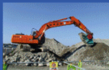
寿都郡寿都町寿都漁港護岸外一連工事
