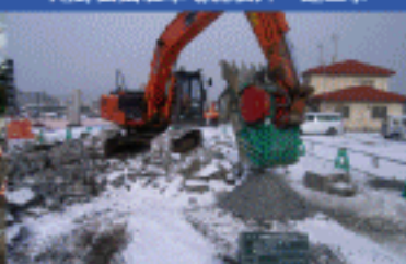
小樽第3号埠頭道路舗装撤去工事
