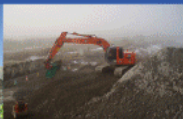
石狩新港-10m耐震岸壁改良工事
