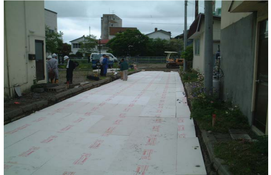
2. ロードライトの敷設
