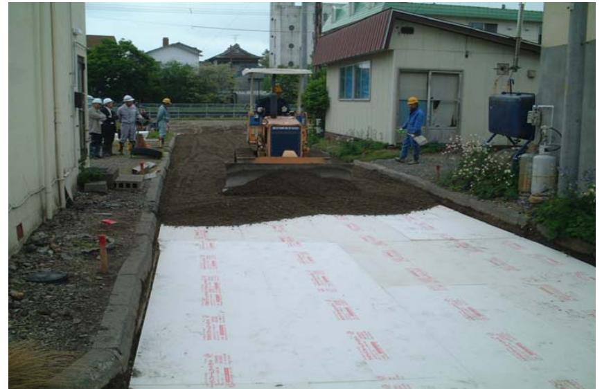
4. 下層路盤材施工
