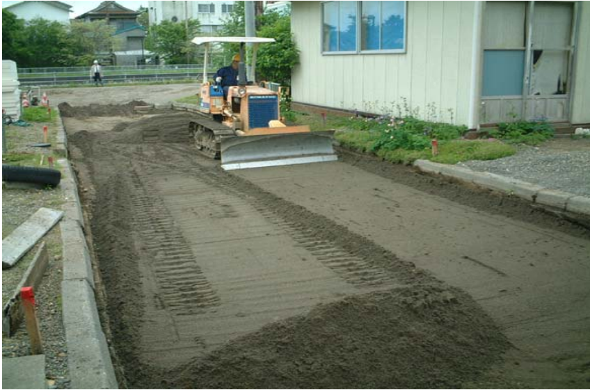
1. ロードライト敷設前の不陸調整砂
