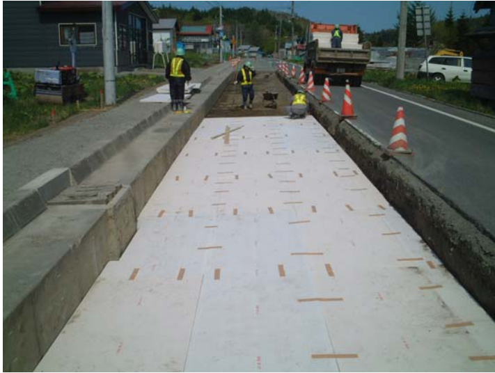
断熱工法施工例
