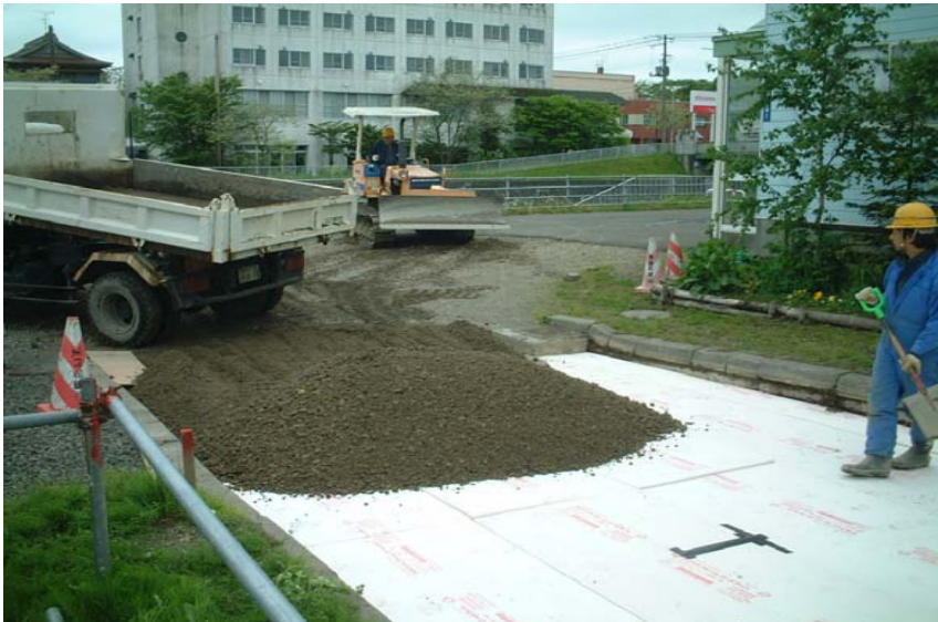
3. 下層路盤材(切込砂利)の搬入
