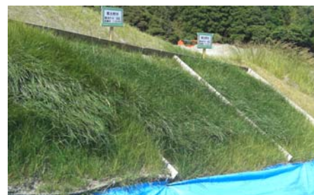
図2 法面緑化状況
