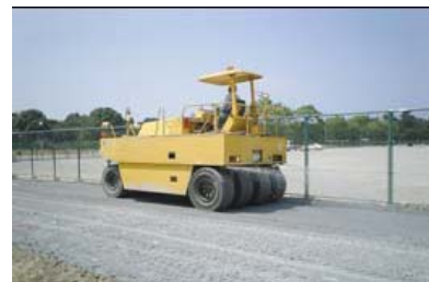
路盤施工状況
