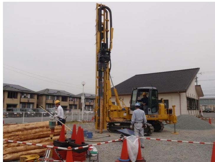
駐車場（三重県松阪市）
