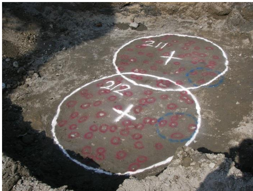
既製杭破碎出来形状況
