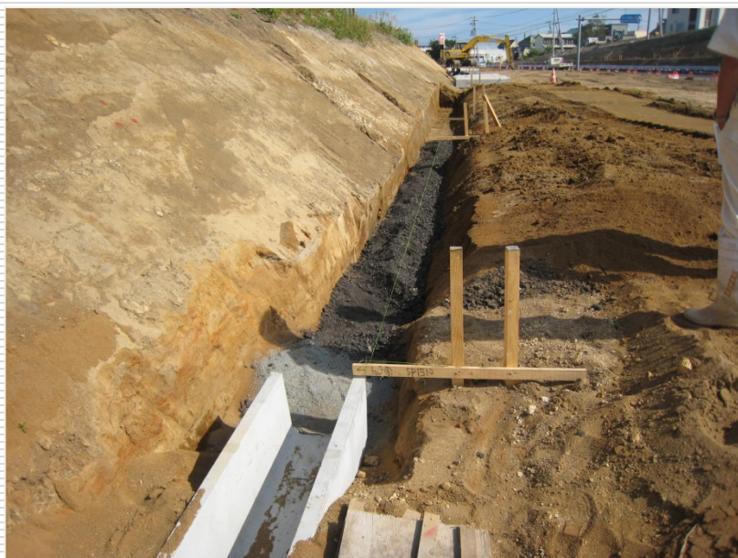
施工中(平成22年度)
