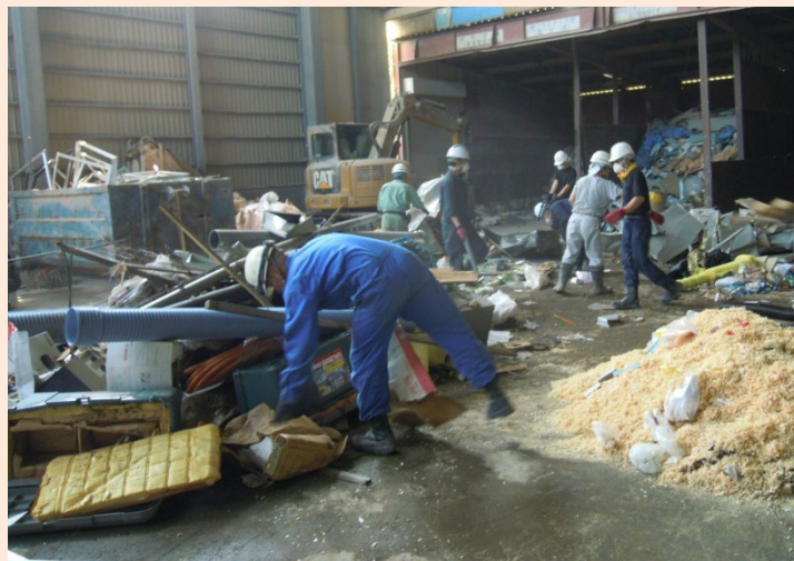
コンクリート土間での選別作業 リサイクル率40～50%
