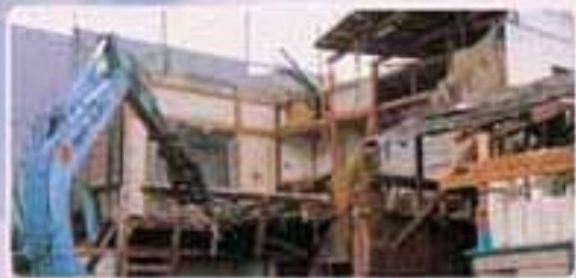
木造住宅解体
