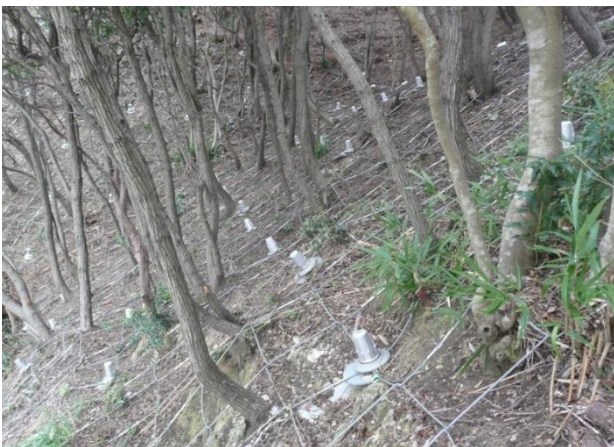
写真-4 施工現場状況写真
