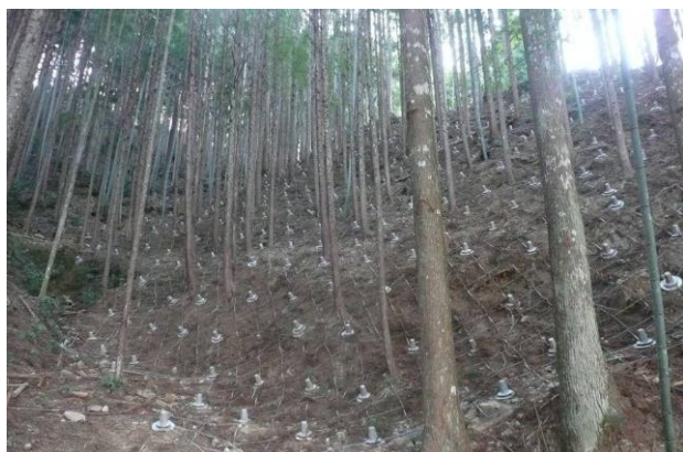
写真-5 熊野古道沿いの施工事例
