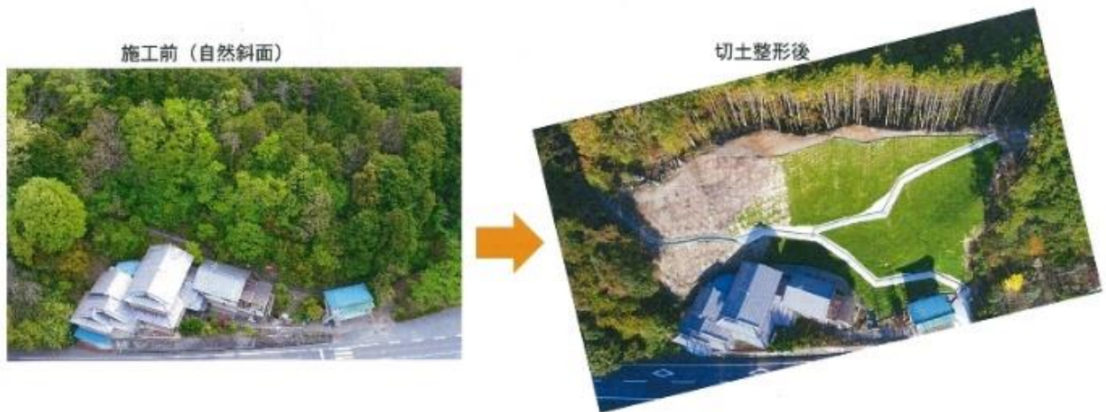
写真-2 切土整形工 (施工前後の比較写真)
