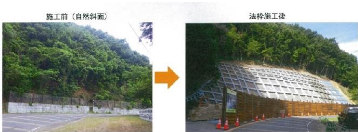
写真-3 法枠工 (施工前後の比較写真)
