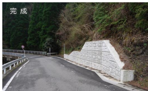
写真-4 掘削残土を低減する施工事例
