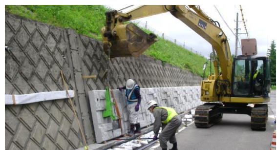
写真-5 産業廃棄物の発生を抑制する施工事例（パネル設置状況）
