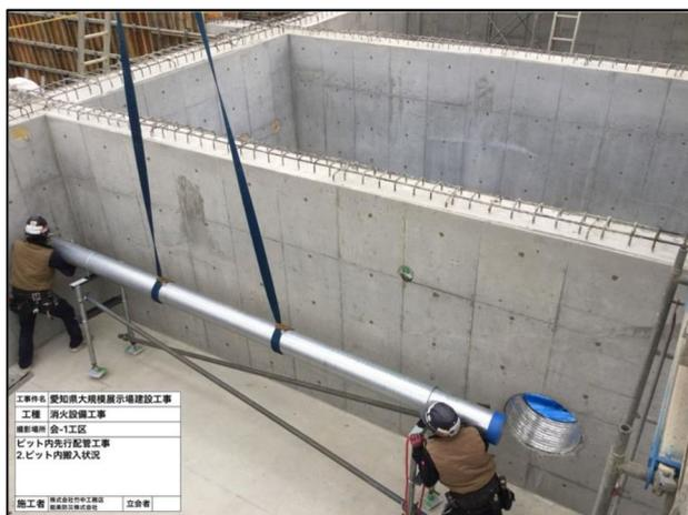
写真8 ピット内先行設備配管施工状況
