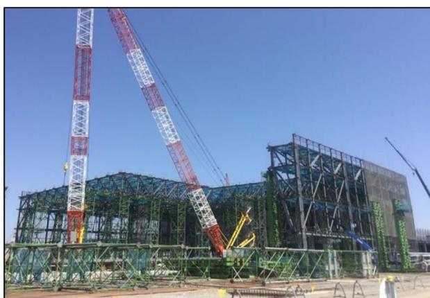
写真 10 大型クレーンによる鉄骨建方状況
