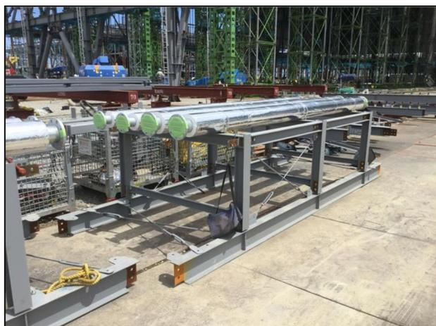
写真9 設備配管ユニット化状況
