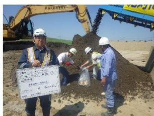
写真 10 混合土の試料採取立会
