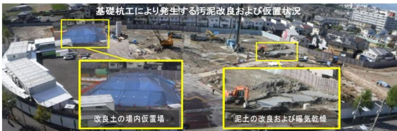
周、地中梁内に随時埋戻しを開始、計画通り約1カ月の工程で終えた。作業では、品質的にも管理された性質で安定しているため、施工（扱いやすさ）や品質管理（埋戻し時の締固め強度の確保等）の面でもメリットがあった。
