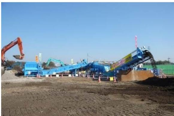
写真1 万能土質改良システム
