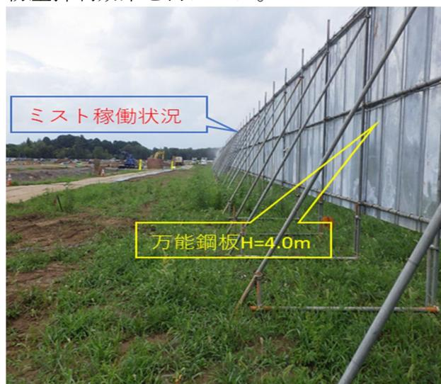
写真-2 粉塵対策付万能鋼板
