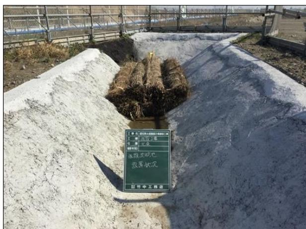
写真 11 既設沈砂池の再利用状況
