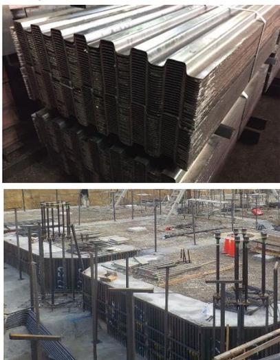
写真-1 キーストン搬入状況と設置状況
