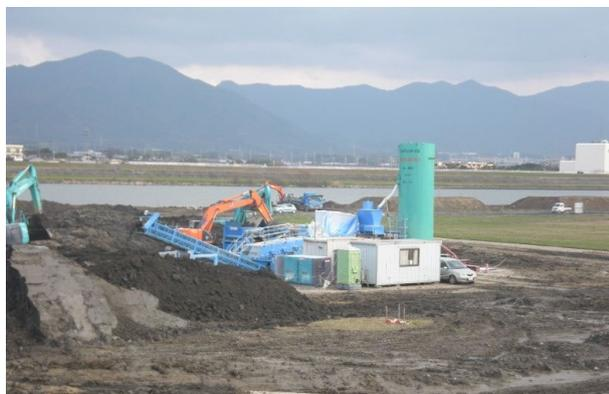
写真7 固化材同時混合設備
