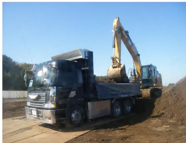
写真-5 発生土積み込み状況
