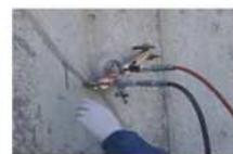
真空吸着型圧力調整注入工法
