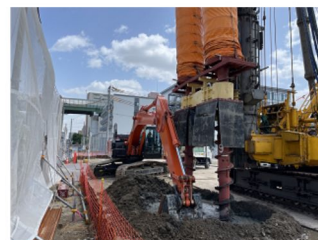
深層混合処理工法
