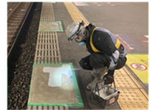
コンクリート・滑止め塗装
