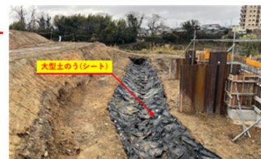
オープン水路の設置状況
