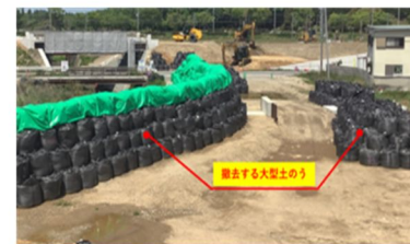
撤去予定の大型土のう
