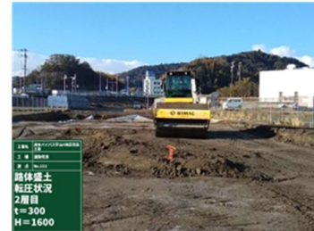
路体盛土工、建設汚泥処理土の活用
