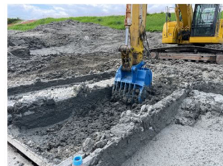
建設汚泥と固化材の混練り
