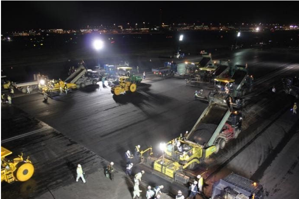
フォームドアスファルト混合物「ecole（エコール）」 施工事例（東京国際空港 C 滑走路中央部舗装改良工事）
