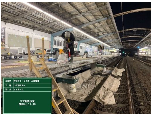
写真-7 コア削孔、削孔水回収
