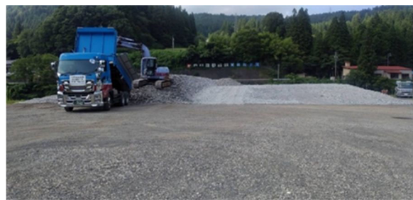
写真2 盛土施工中の状況
