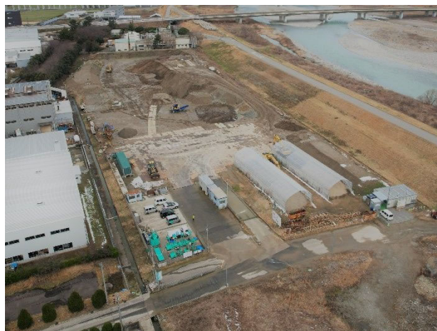
写真-1 建設発生土ストックヤード
