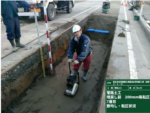
写真-7 リサイクル土による管路埋戻し状況
