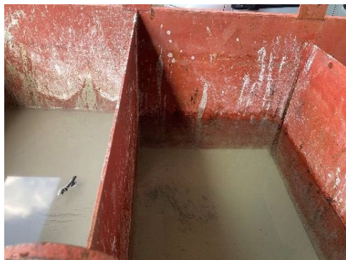
写真-9 沈殿槽（内部）
