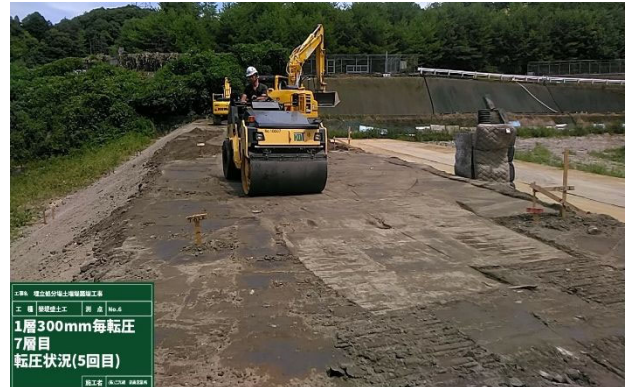
写真-9 土堰堤盛土の転圧状況
