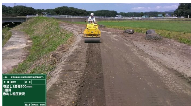
写真-5 築堤盛土転圧状況
