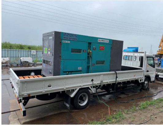
図8 発電機でBDF 利用
