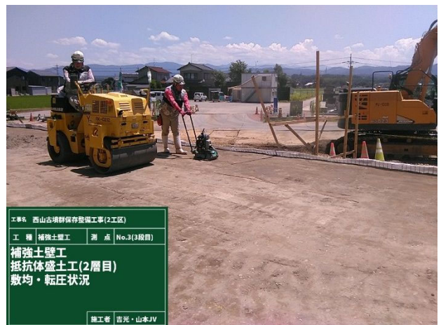
写真-4 リサイクル土の敷均し転圧状況
