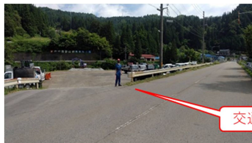
写真3 入口の状況(交通誘導員配置)
