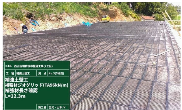
写真-3 補強材敷設状況
