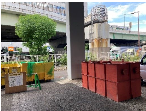
写真-8 沈殿槽
