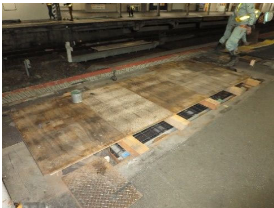
写真-1 木製仮覆工事例
