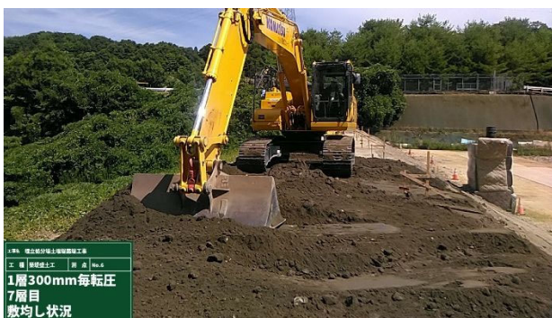
写真-8 土堰堤盛土の敷均し状況
