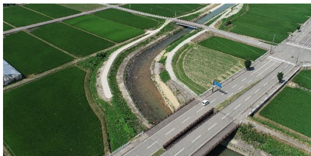
写真-6 築堤盛土完成状況
