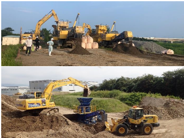
写真-2 リサイクル土の製造状況
