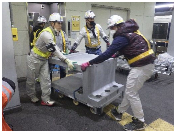
写真-5 基礎運搬(エレベーター使用)
