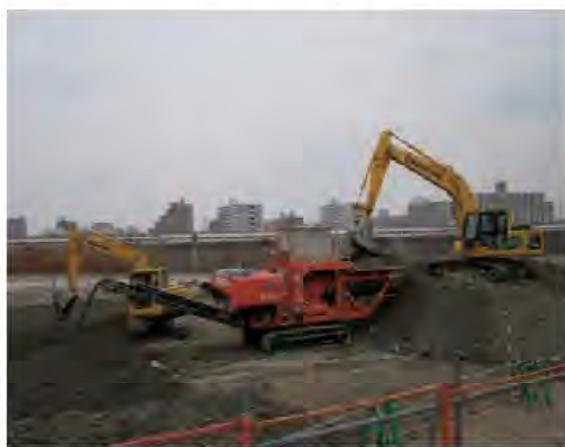
移動式土質改良機による連壁発生泥土の改質利用
